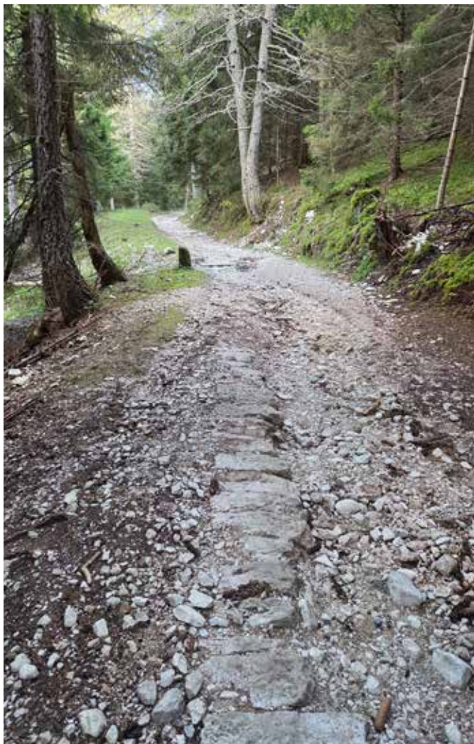
Materiale derivante dal dilavamento della sede stradale e sversamento dello stesso nelle sottostanti proprietà private.
